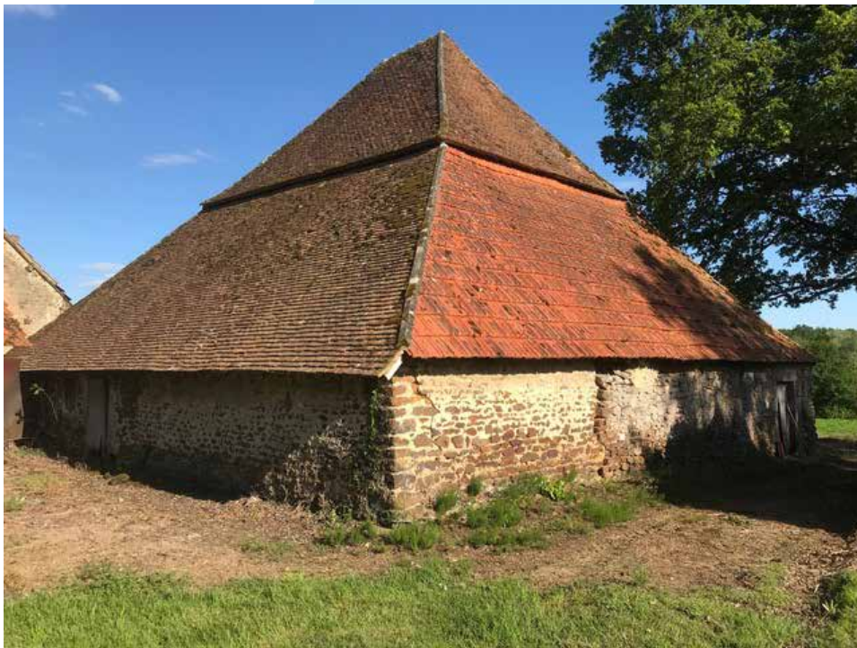
Grange pyramidale du Joliveau à Assigny
